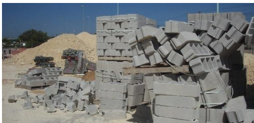
Rotura de material por acopio indebido
